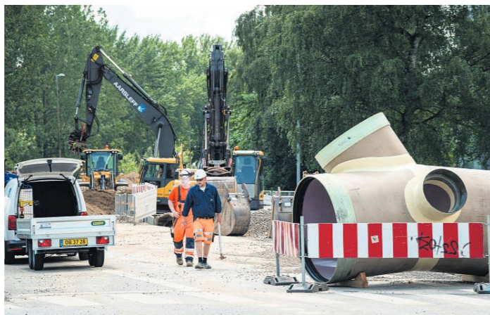
De nye store kloaker er blevet gravet ned i Strandvejen-Indre Ringvej og krydset ved Jernbanegade. Siden april har trafikanterne skullet via Holstensvej for at komme ind til byen. Til midnat åbner krydset og Strandvejen igen. Arkivfoto: Peter Leth-Larsen
