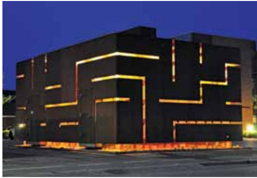
Pumpestationen i Oldenborggade fik en arkitekturpris i 2010. Slidserne i beklædningen oplyses om aftenen i varierende farver og forvandler pumpestationen til en spændende lyskulptur.
